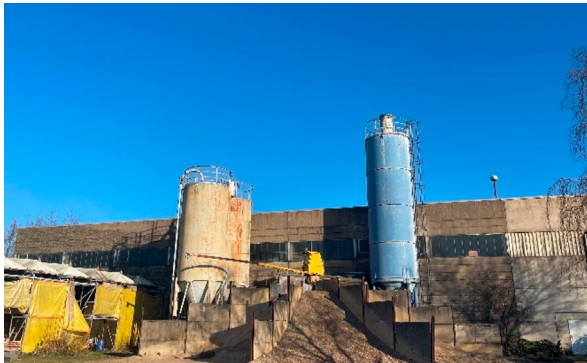
Produktionshallen mit Erweiterung (heller Teil)
