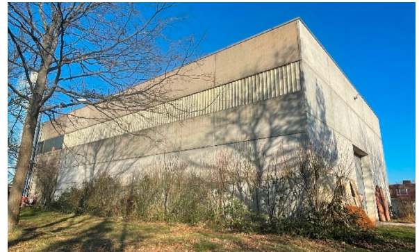
Produktionshallen mit Erweiterung (heller Teil)
